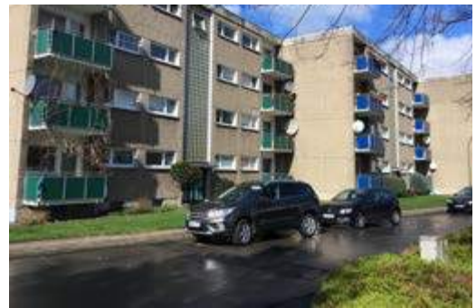
Foto 85: Beispiel Maßnahmengegenstand Maß. III 5 (hier: Geschosswohnungsbau der 70er Jahre)
