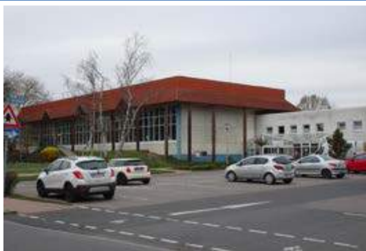
Foto 83: Potentialfläche (nach Abriss des Hallenbades)
