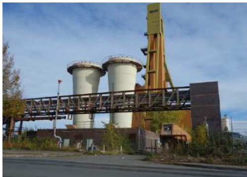
Foto 73: Lüfter und Betriebsgang
