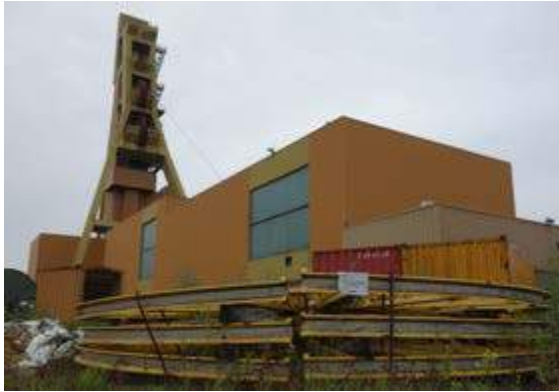
Foto 23: Förderturm und Maschinenhalle
