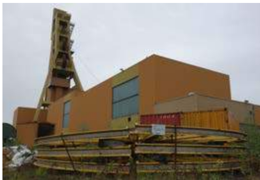
Foto 72: Maschinenhalle und Förderturm
