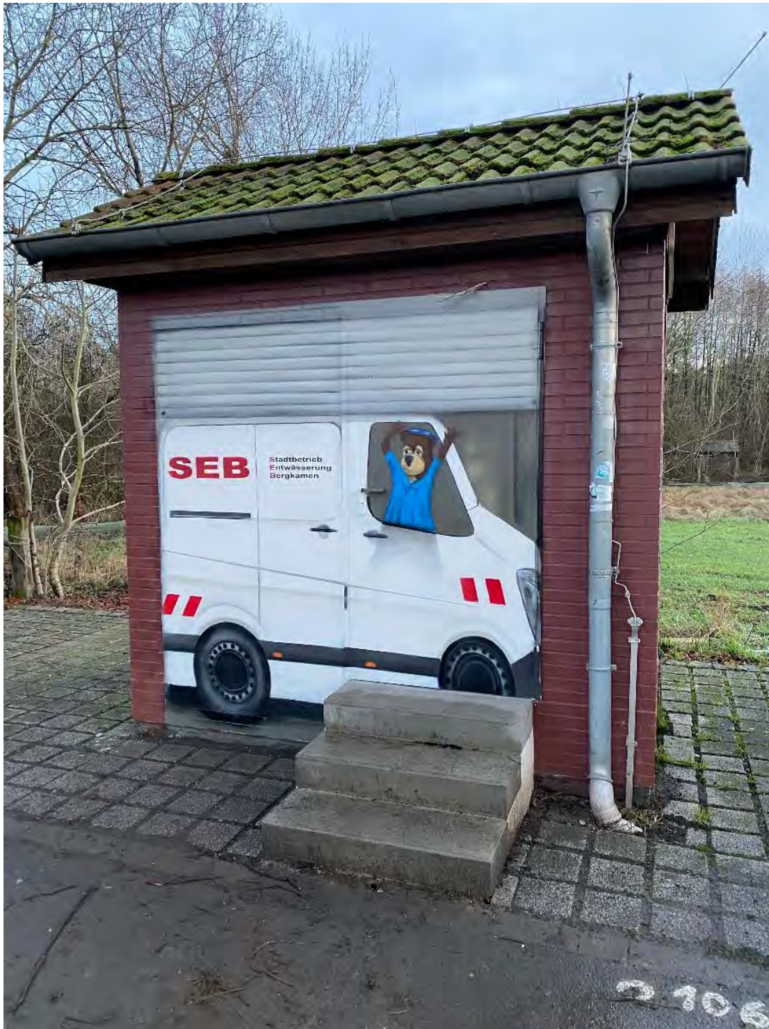
(Pantenweg nach Umbau. Quelle: Stadt Bergkamen)
