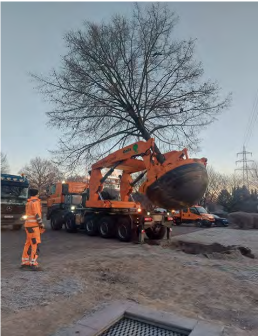
Großbaumverpflanzung Realschule Oberaden
