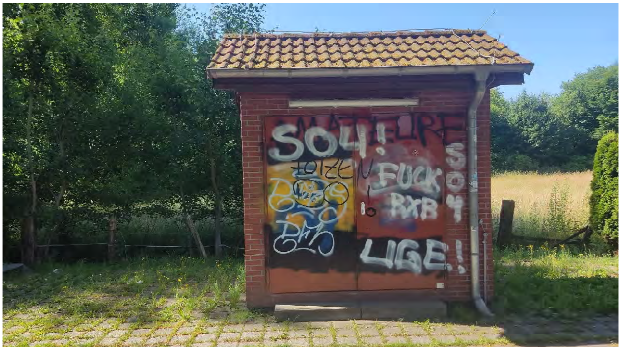
(Pantenweg vor Umbau. Quelle: Stadt Bergkamen)
