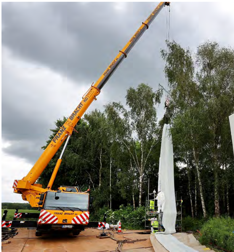
(Sanierung mittels Inliner mit Kran. Quelle: Stadt Bergkamen)
