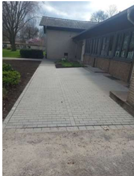
Abbildung 26: Zuwegung Overberger Grundschule nachher
