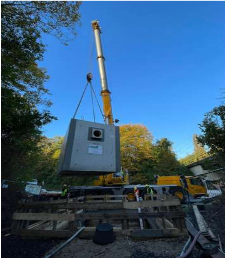
Abbildung 132: Einbau Lamellenklärer
