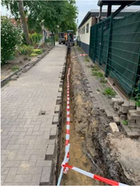
Abbildung 31: Rohrgraben "Auf den Goldäckern" 1
