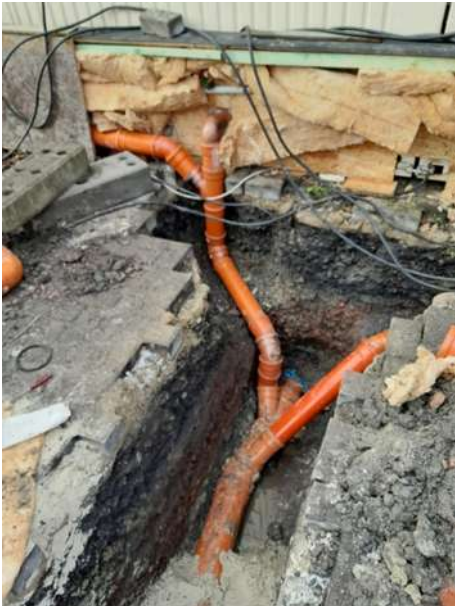
Abbildung 33: Anschluss Duschcontainer
