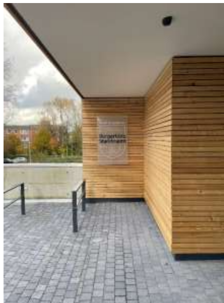
Abbildung 56: Neuer Eingang Bürgerbüro
