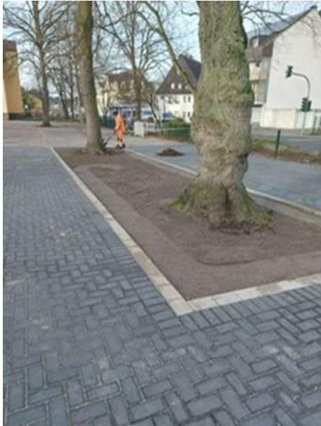
Abbildung 23: Baumscheibensanierung Kettlerschule vorher
