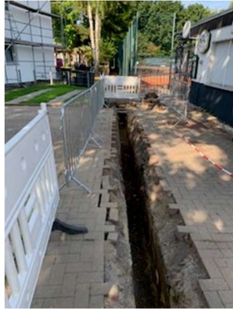
Abbildung 32: Rohrgraben "Auf den Goldäckern" 2
