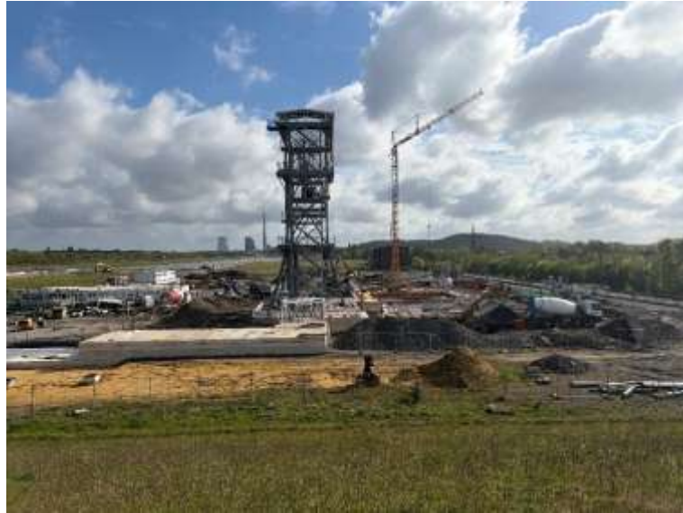
Abbildung 110: Baustelle RAG AG
