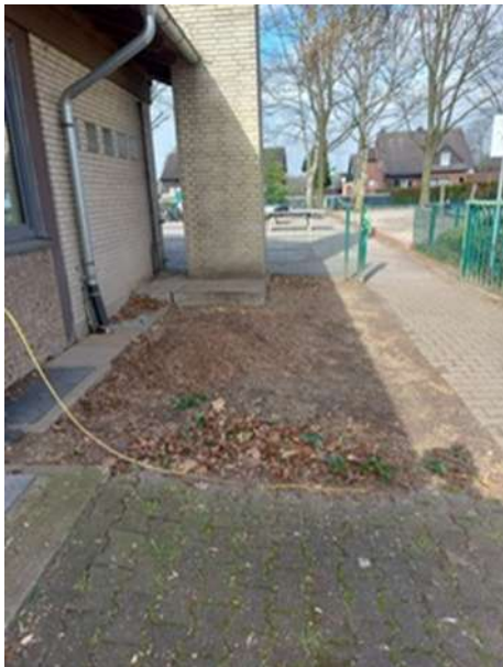
Abbildung 25: Zuwegung Overberger Grundschule vorher
