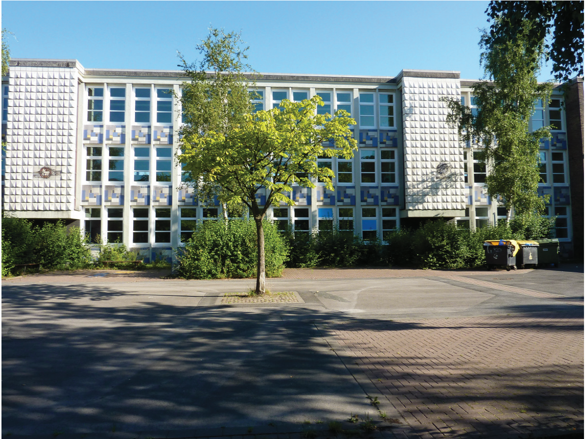
Abb. 8 Willy-Brandt-Gesamtschule, Abt. 5 – 7 (vor der Fassadensanierung)
