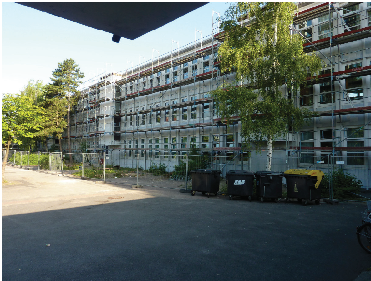
Abb. 10 Willy-Brandt-Gesamtschule, Abt. 5 – 7 (während der Fassadensanierung)
