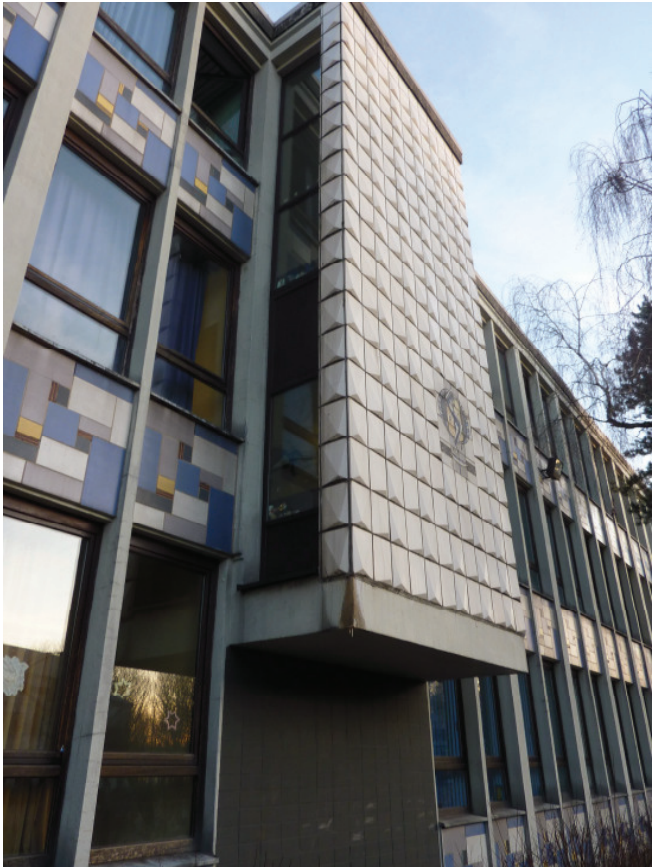
Abb. 9 Willy-Brandt-Gesamtschule, Abt. 5 – 7 (vor der Fassadensanierung)
