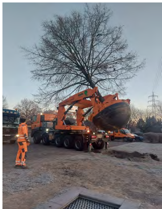
Großbaumverpflanzung Realschule Oberaden
