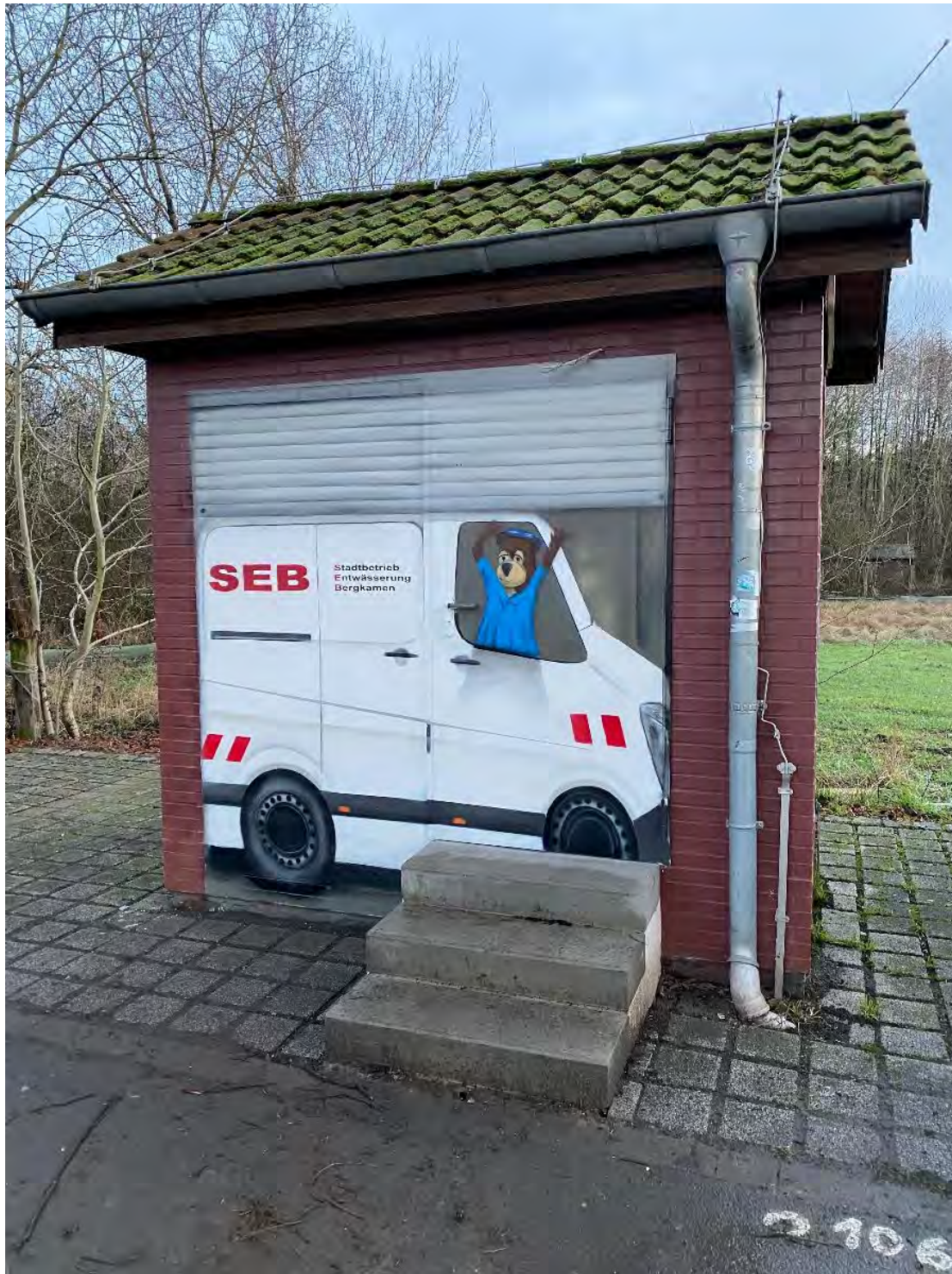
(Pantenweg nach Umbau. Quelle: Stadt Bergkamen)
