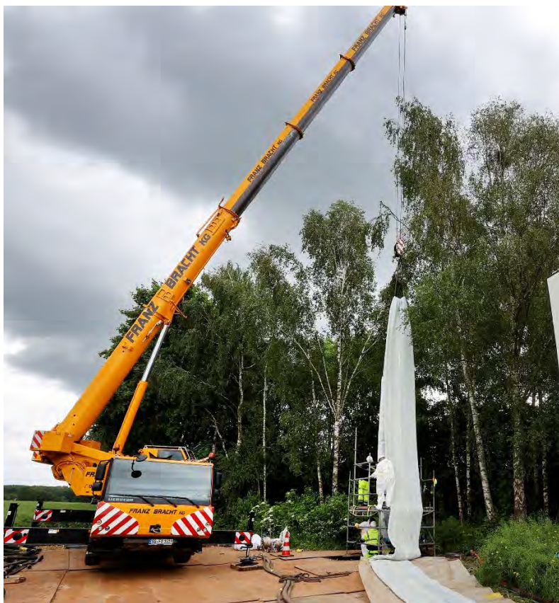
(Sanierung mittels Inliner mit Kran. Quelle: Stadt Bergkamen)
