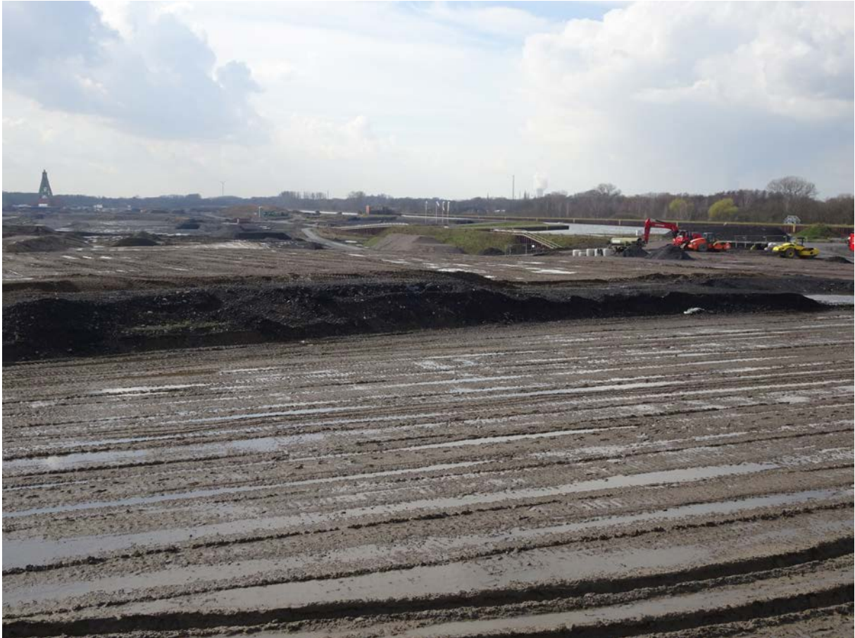
Abbildung: Baustelle Wasserstadt (Quelle: Stadt Bergkamen)
